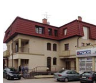
Gotov objekt nakon rekonstrukcije
